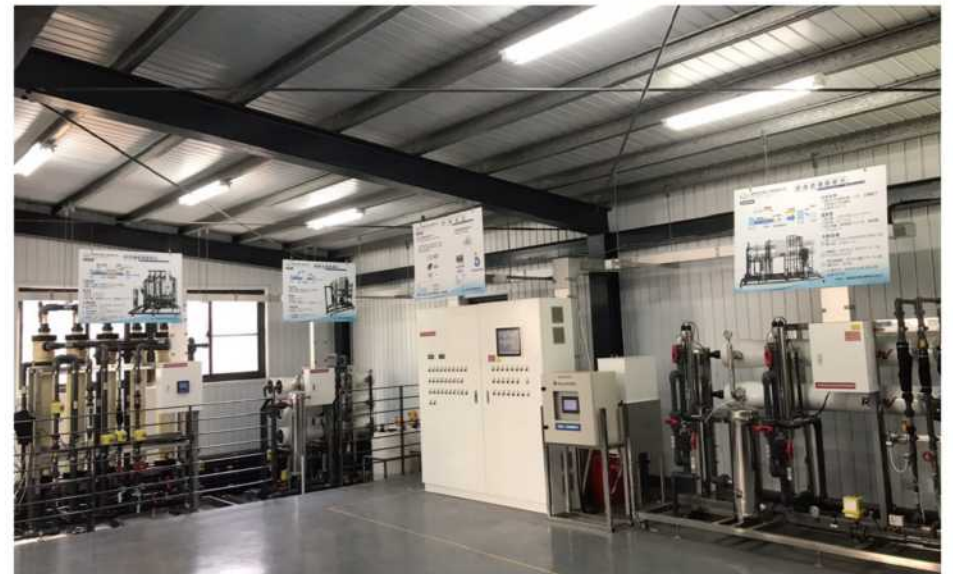
「再生水類產線工廠」黑水變藍金的核心設備－超過濾薄膜單元、機電控制設備與逆滲透薄膜單元
